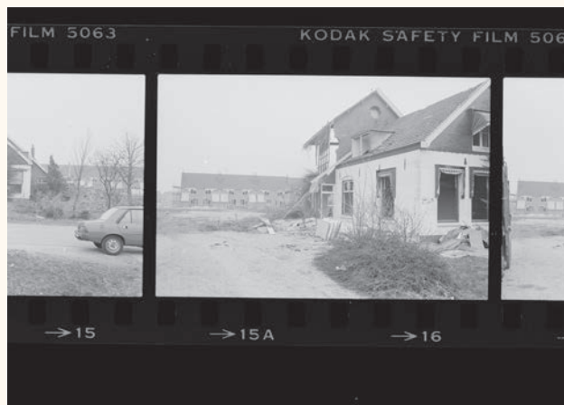
Afbeelding 2: Sloop boerderij IJweg 1031 met nieuwbouw
